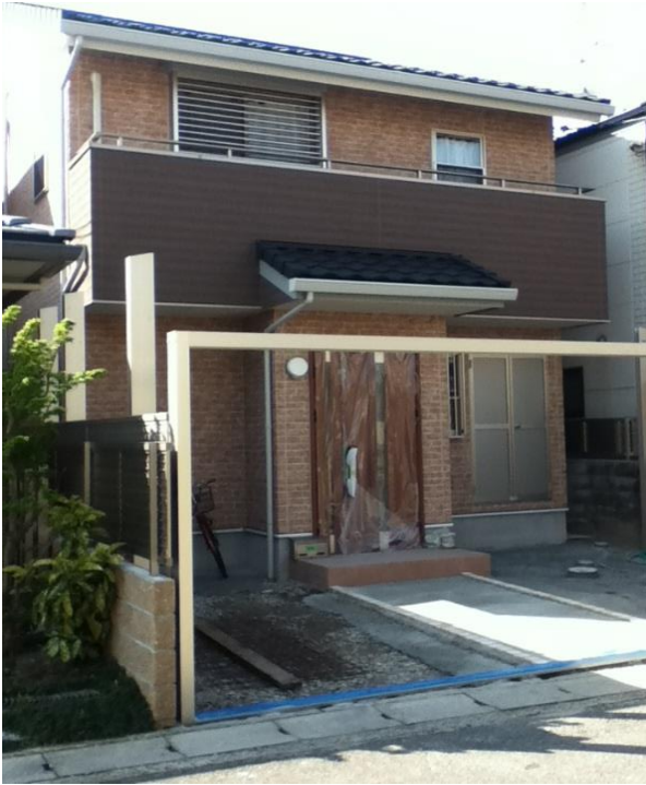
ただ今、外構の工事中。
